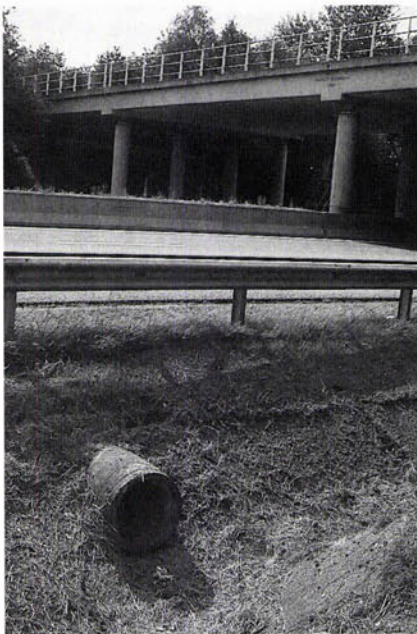
FIGUUR 10. Voorbeeld van een droge duiker die door een Bunzing wordt gebruikt. Op het viaduct is een doodgereden Greppelsprinkhaan gevonden. Let op de dichte betonnen vangrail (Berlijnse muur) in de middenberm van de snelweg (dia: S. Jansen).
